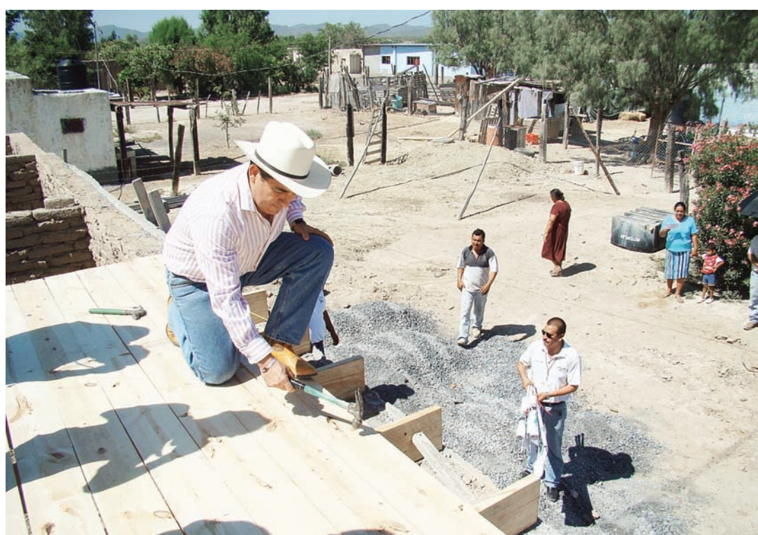
EN EL EJIDO La Leona, el alcalde Ramón Ocegüera inició el programa Tu Casa Rural, en el techo de una viviendas dañadas por el paso de las lluvias.
